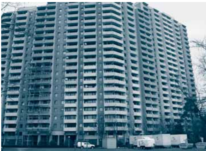
Vom Einfamilienhaus bis zu Hochhauskomplexen – Wasserrohrsanierung durch Donauer & Probst
